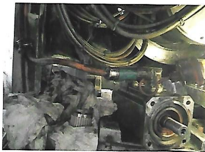
Les dégâts sont apparents sur les câbles, roulements, vis et glissières avec filtration papier
